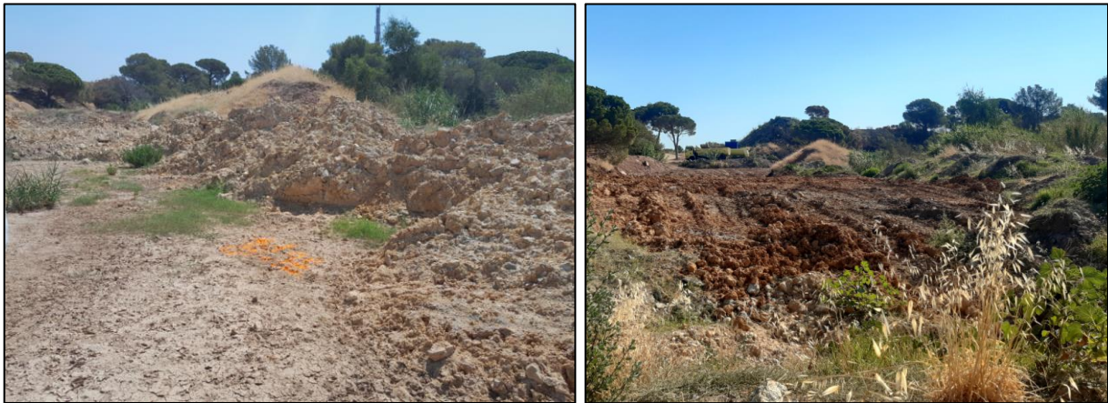
Figure 3. Photographies du site datée du 14/06/2022 (à gauche) et du 03/08/2022 (à droite) témoignant d'un remodelage fréquent en déblais/remblais
